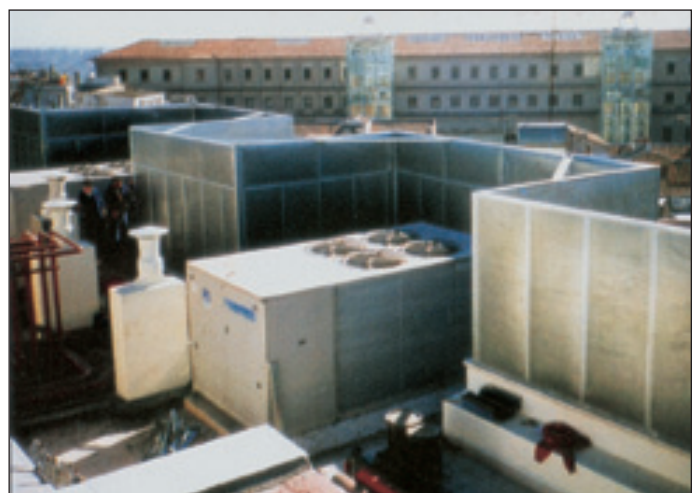
Gráfico 2 Reducción de ruido por apantallamiento
